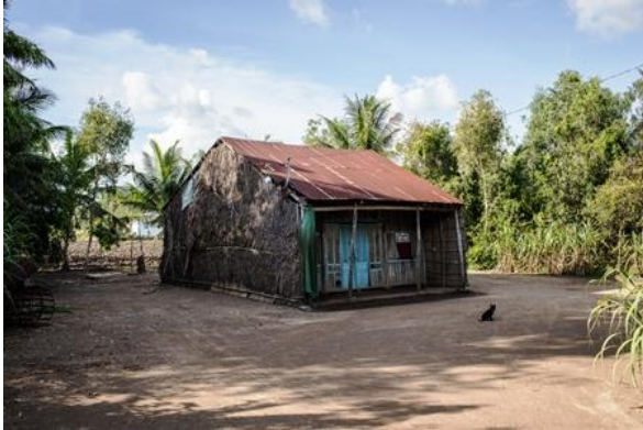
Một căn nhà hoang tại Kiên Giang - chủ nhân đã bỏ đi Bình Dương vì nợ nuôi tôm.
