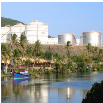
Bồn dầu tại nhà máy lọc dầu Dung Quất
