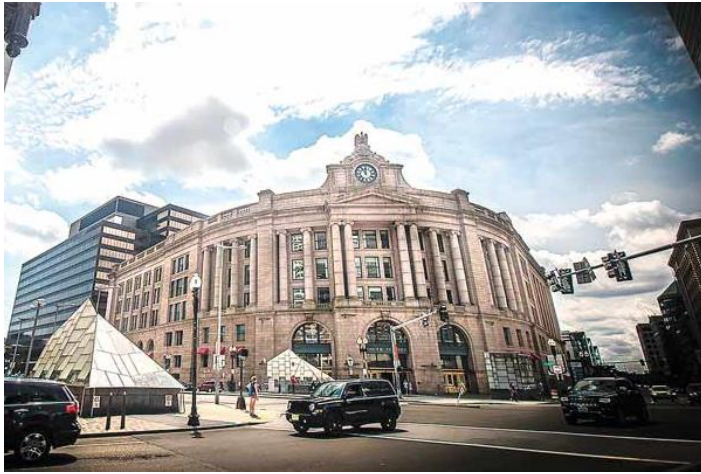
Nhà ga phía Nam Boston. Photo. hdv
