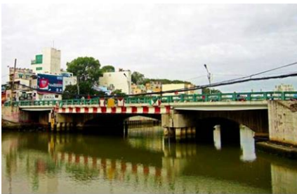
Cầu Bông cũ trước khi được xây mới vào năm 2013. (Ảnh: Panoramio)
